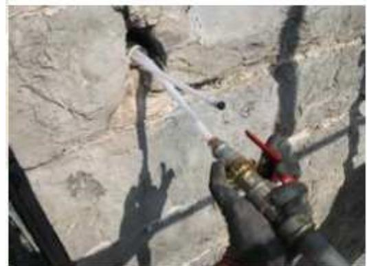
L'iniezione di miscela legante permetterà di eliminare il pericolo di disgregazione caotica della muratura andando a ridurre i vuoti e rafforzando il legame tra le parti esistenti della muratura, rendendo in tal modo la muratura più coesa ed in grado di mantenersi monolitica durante il sisma.
