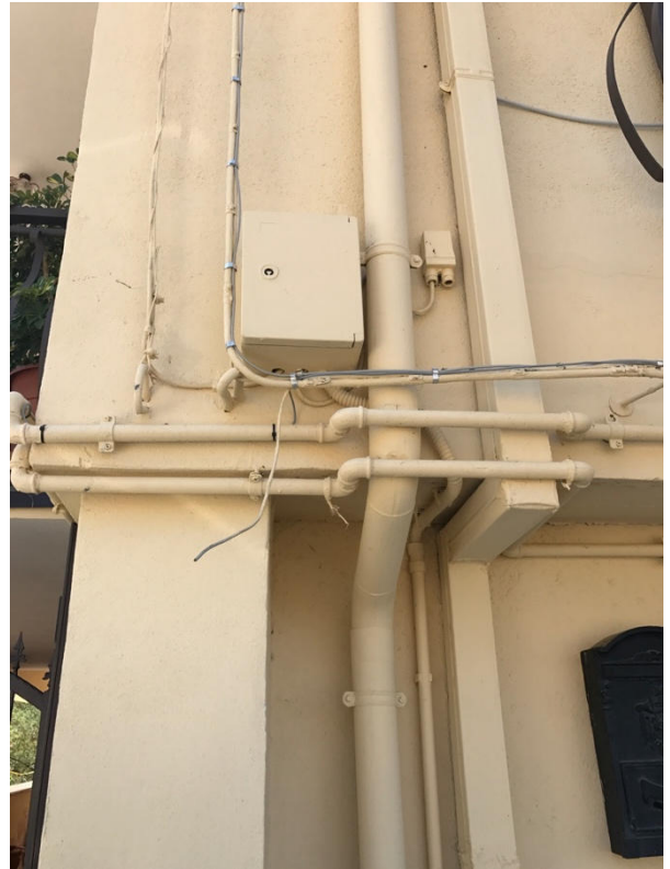
FOTO 2. – Quadro elettrico Q11
