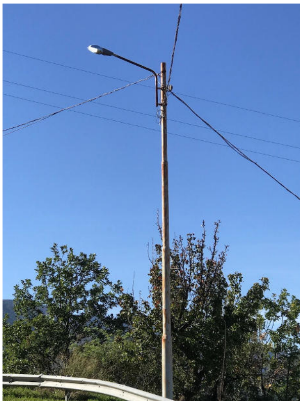
FOTO 8. – Armatura Stradale P.B. LED E27
