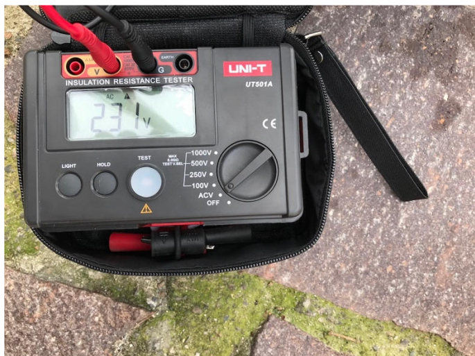
FOTO 21. – Caduta di tensione a fine linea
